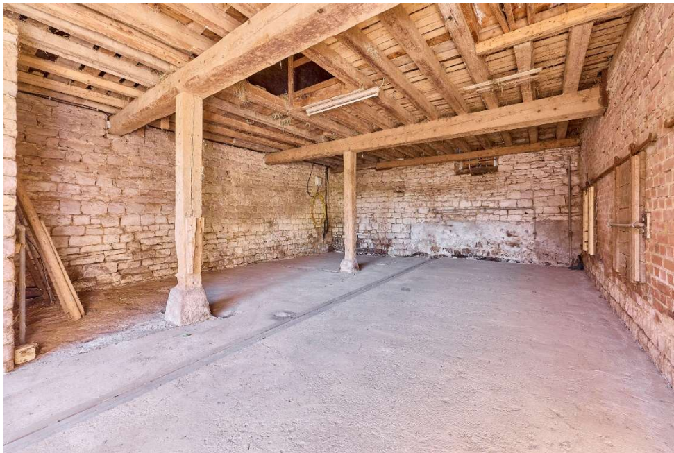
Großzügiger Scheunenbereich mit breiter Toreinfahrt, massiven Bruchsteinwänden und historischer Holzkonstruktion
